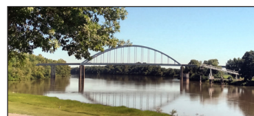
Bridge in Des Arc, Arkansas.
